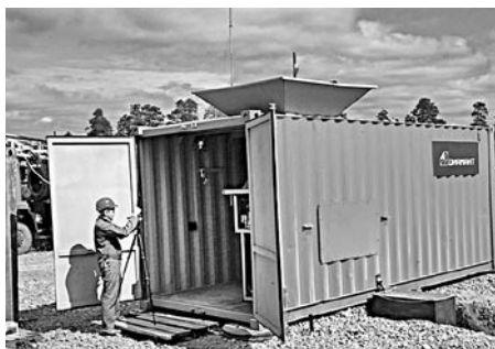
Внешний вид установки. Август 2015, Архангельск
